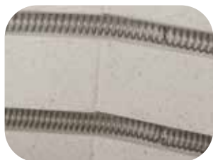
Topné články chráněné v drážkách
