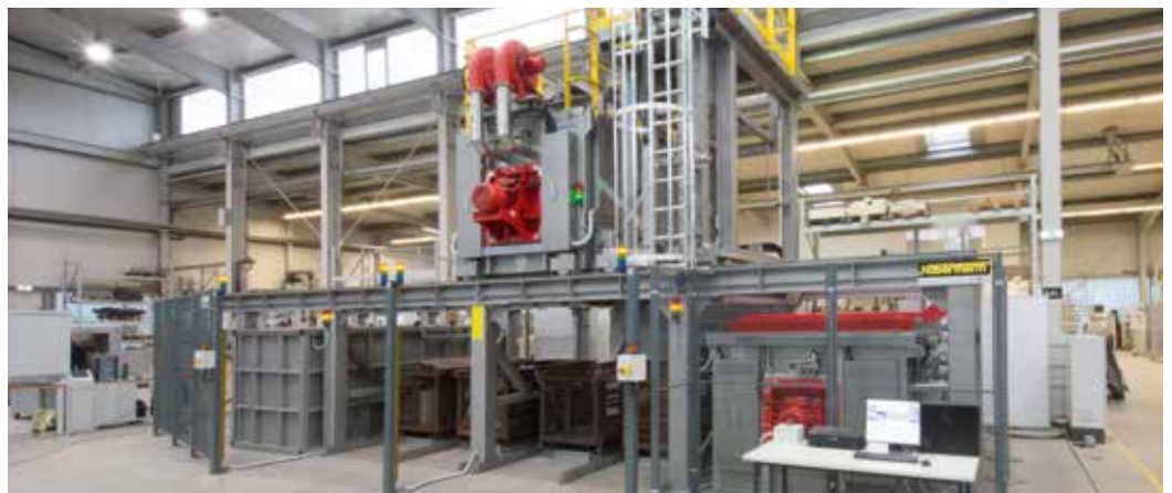
Installation de four à trempe verticale pour l'Aluminium
