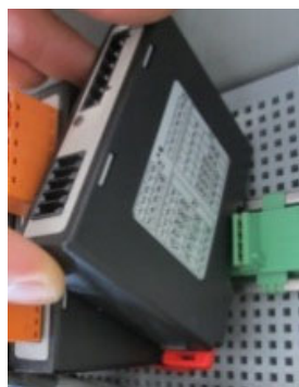
Att. 18: regulēšanas moduļu demontāža – 2. daļa (skatīt attēlu)
